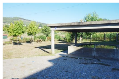
Foto 32 Il lavadero del km10 con area di sosta
