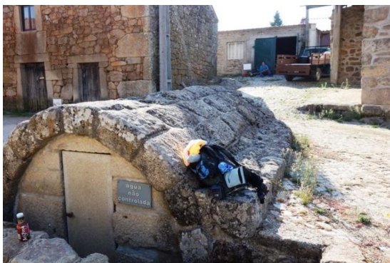
Foto 18 Povo del Rey: la cisterna di acqua buona
