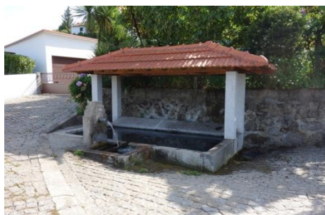
Foto 28. Il lavadero prima di Felgueiras
